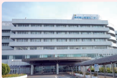
南和歌山医療センター 本館正面外観
